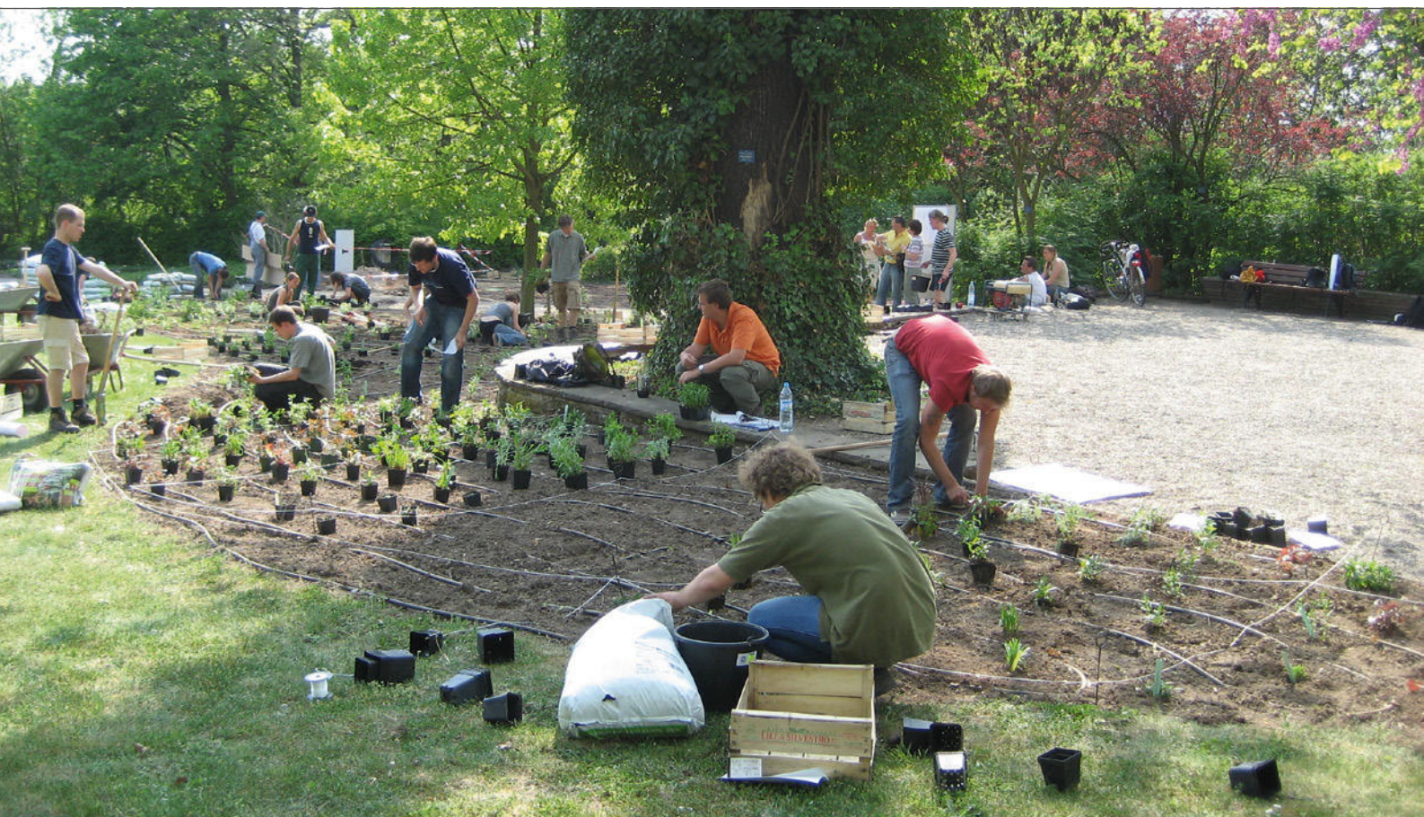
Anlage einer Staudenfläche mit Unterflurbewässerung (druckkompensierte Tropfer) mit Studierenden am Campus der Hochschule Geisenheim University. | Fotos: Prof. Dr. Roth-Kleyer
