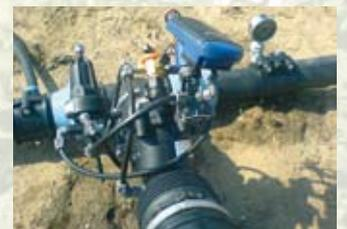
Magnetventil mit Steuereinheit AquaPro
