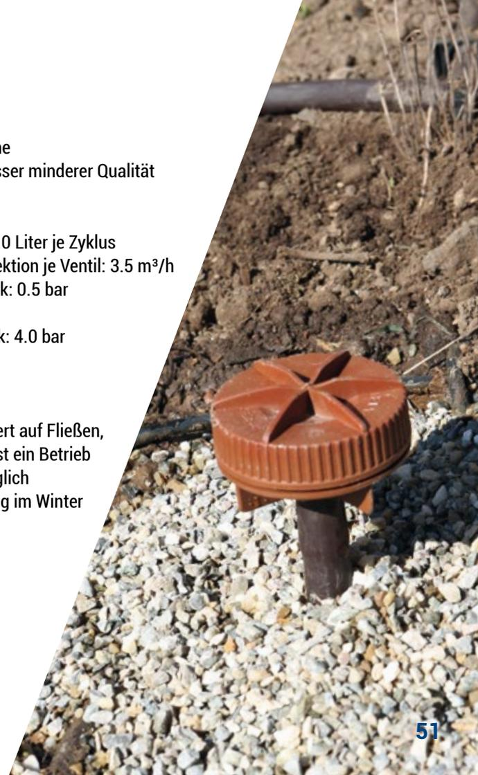
Kombination Vakuumunterbrecher und Entlüftungsventil
