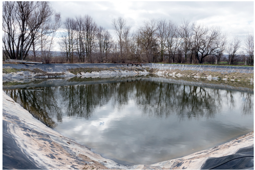
Der Tagesspeicher für die Pumpenanlage des Beregnungssystems fasst etwa 2.500 m 3 Wasser.
